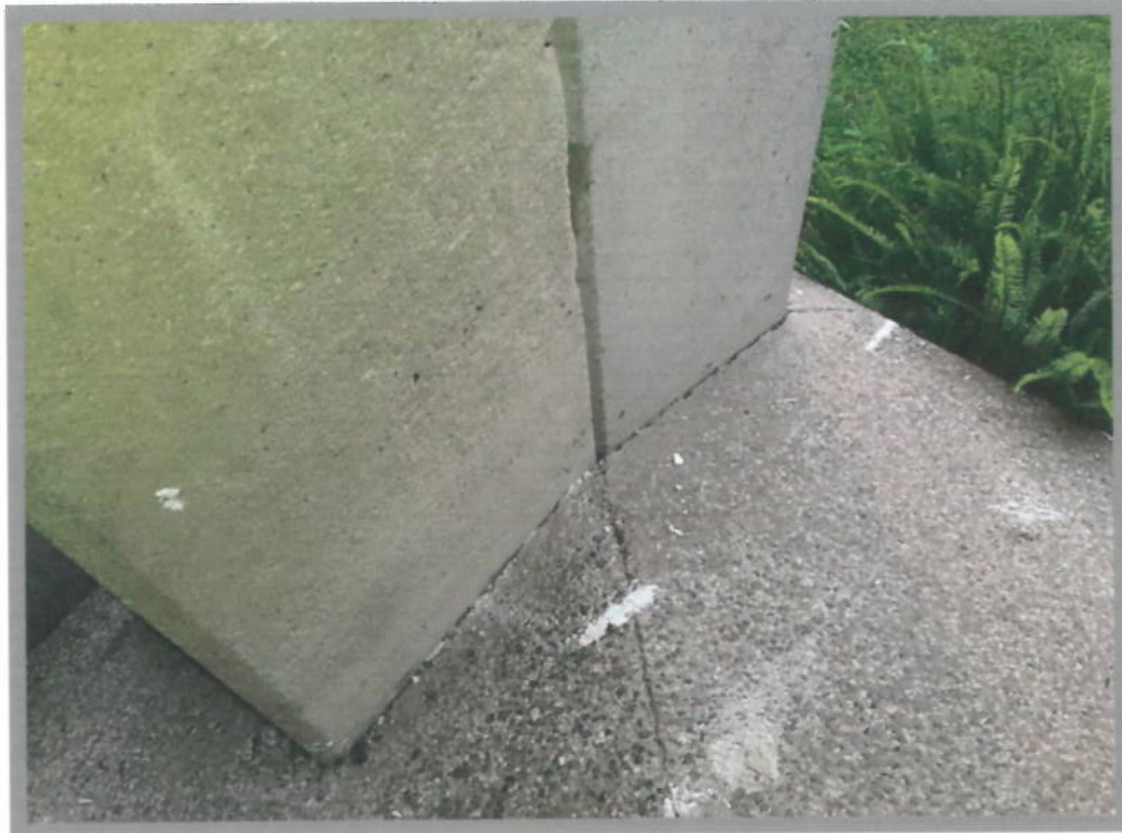
Foto 13 Columna falsa por acabado arquitectónico o para alojar instalaciones y columna estructural sin daños
